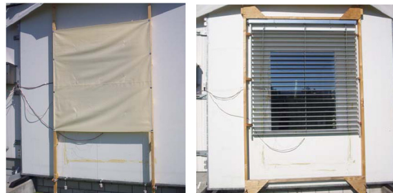
Abbildung 5 Außenansichten der Fassade
